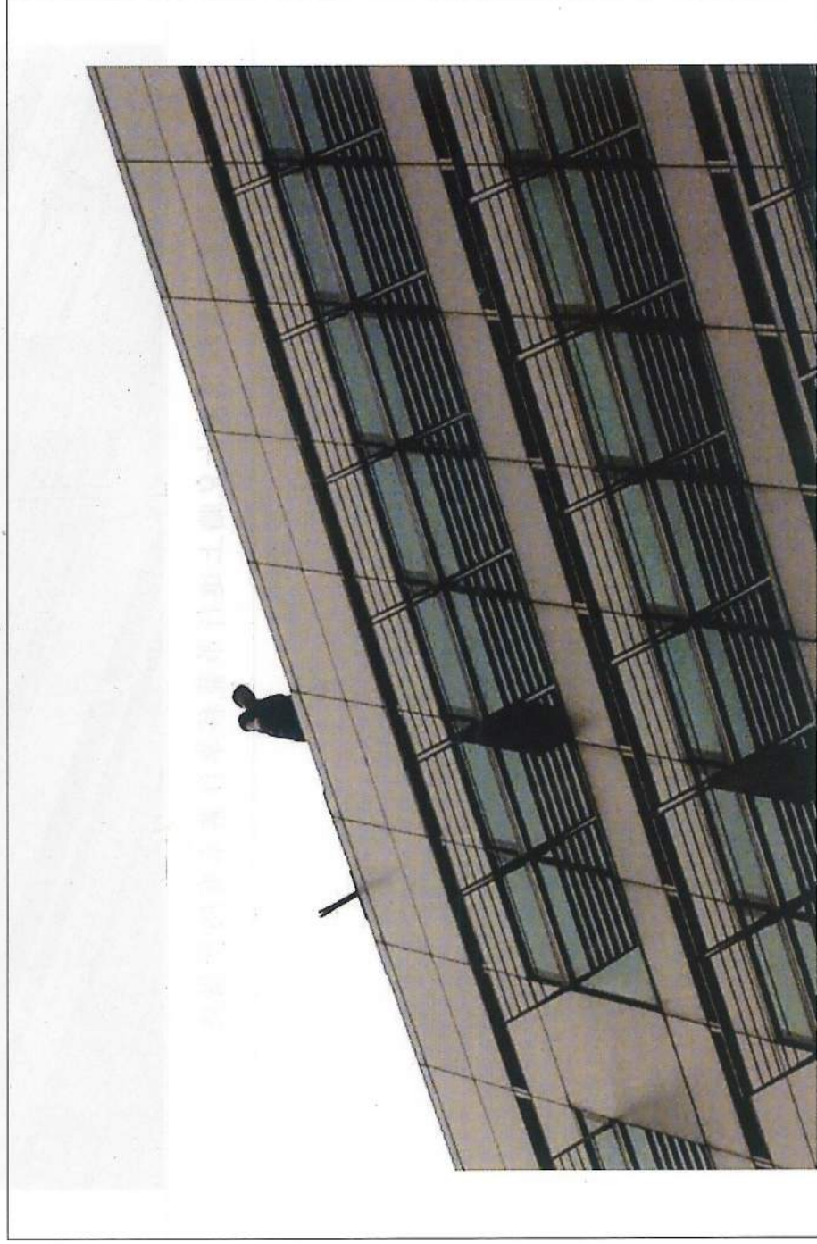
作業人員於頂樓女兒牆上進行吊籠移車作業未有防墜措施
